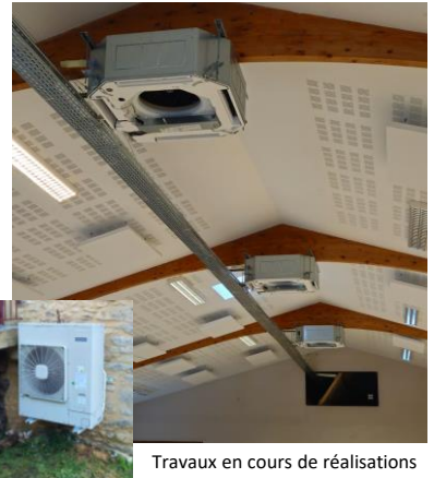
Travaux en cours de réalisations
